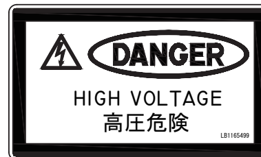
本体上面内部 （分岐部左側面 高電圧カバー部）
